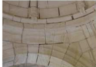
Photo 4 Joints abimés
