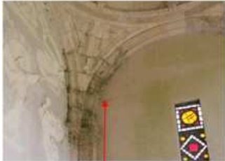
Photo 3 Trace d'humidité Purge et changement de pierres
